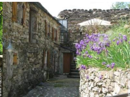
Steingebäude mit Charme
