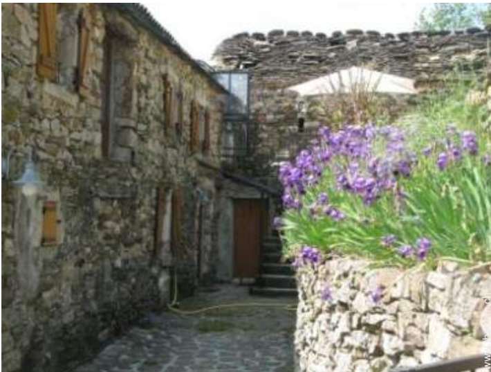
Steingebäude mit Charme
