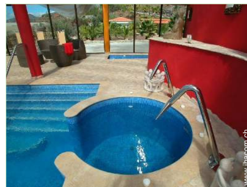
Swimmingpool in Wohnanlage
