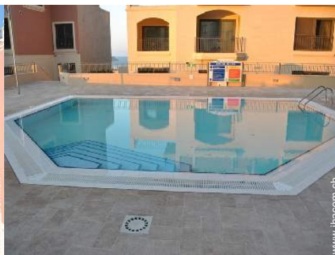
Swimmingpool in Wohnanlage
